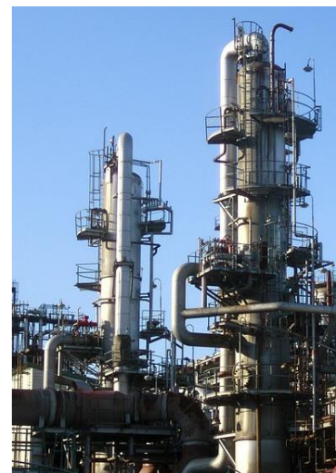
図18 原油精製設備
